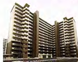
令和元年竣工 大阪市営住宅
